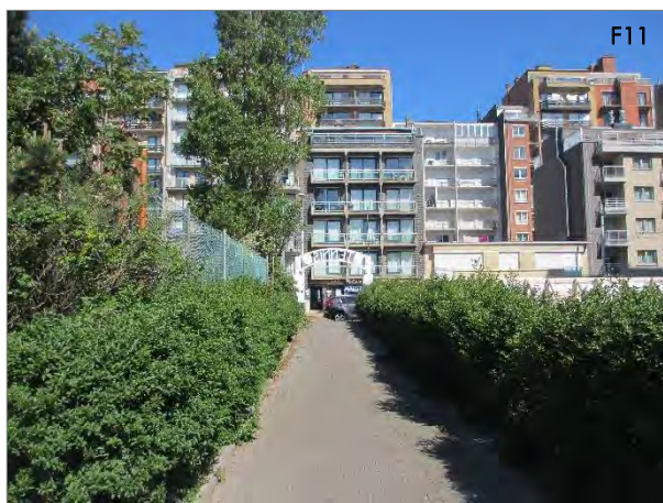
Zicht op voetgangers/fietsers doorgang doorheen plangebied richting de Leopoldlaan
