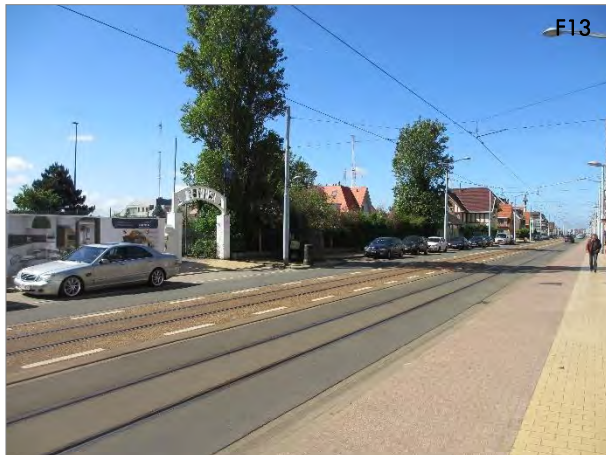
Zicht vanaf de Leopoldlaan op het plangebied
